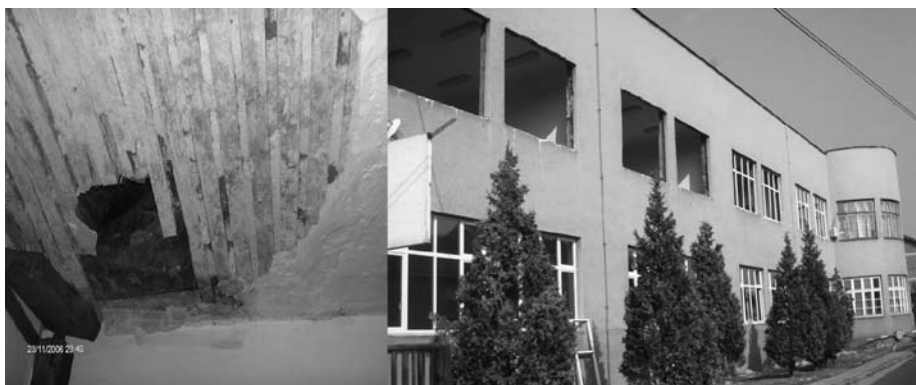
Слика 5 – Оштећени приватни и јавни објекти
